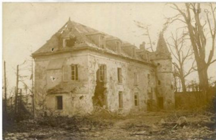
La façade sur la cour d'honneur au cours de la guerre
