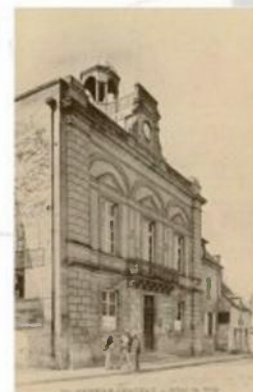
L'hôtel de ville d'avant 1914 occupait l'emplacement de l'entrée de la forteresse
